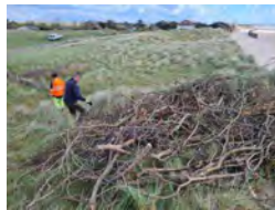
Pose de fascines par la COCM Pointe du Banc - Avril 2024
