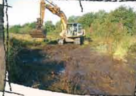
Étrépage à la pelle mécanique
