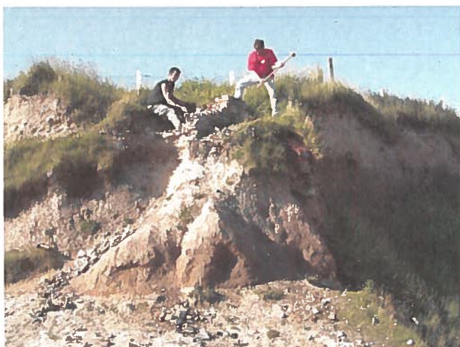
Sécurisation du sommet de la falaise - Cl. A.L. Mauduit
