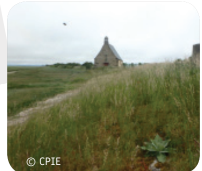
Digue de la Chapelle Ste-Anne (35)
