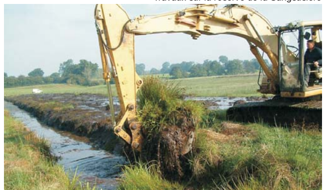
Travaux sur la réserve de la Sangsusièrre
