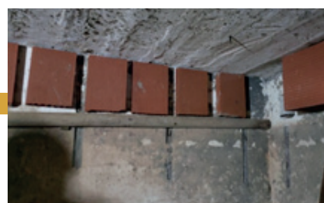
Installation de briques creuses dans un blockhaus
